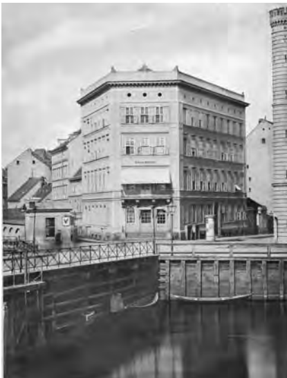
(Abb. 4) Augenklinik Albrecht von Graefes, Karlstraße 46 in Berlin, ganz in der Nähe der Charité. Im Vordergrund die Unterbaumbrücke (B a 6). Ende 1852 mietet von Graefe hier zuerst zwei Zimmer, später ein Stockwerk, bald schon das ganze Haus an. Im Laufe der Jahre entwickelt sich seine Klinik auf operativem Sektor europaweit an die erste Stelle. [23]
